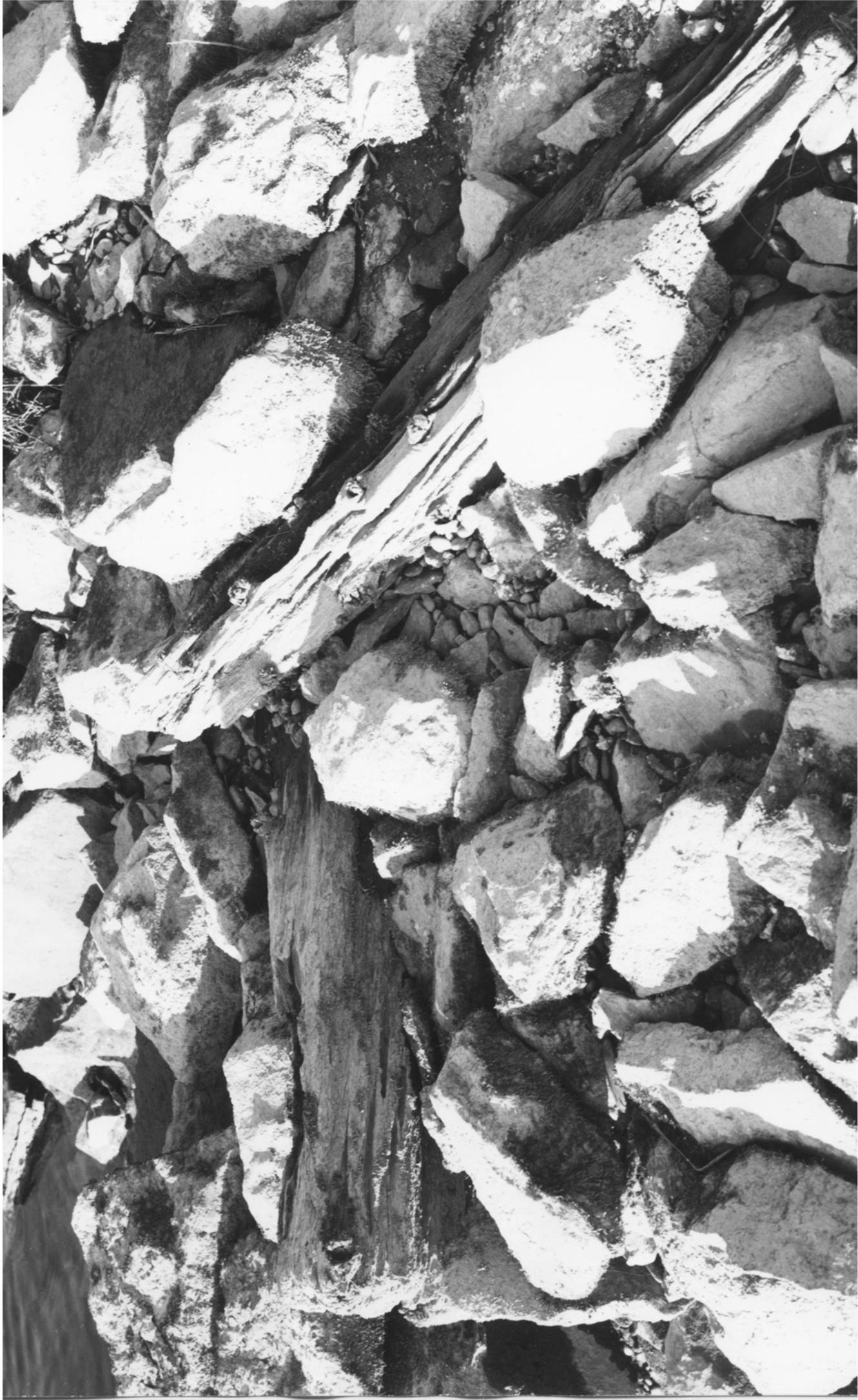
Pile n° 14 (n° 9 selon la CNR) - Système de poutraison pris dans les maçonneries - 16 décembre 1969
