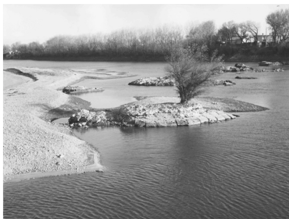
Fig. 7 - Pile 7-CNR (cliché AV.177 CNR 16/12/1969)
