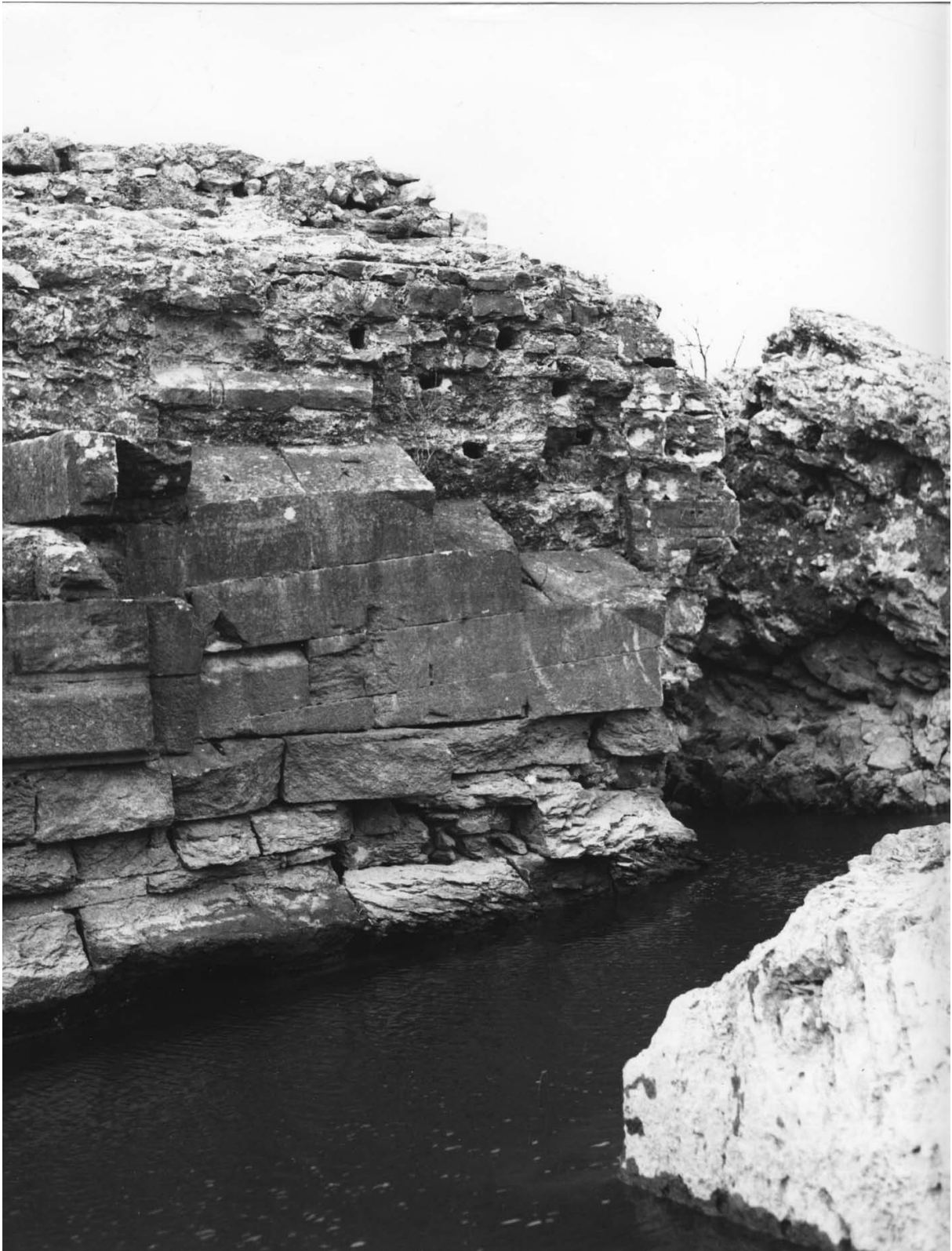
AV 165 – Pile 6, en 1969 avant dérasage selon la CNR (pile n° 17)
