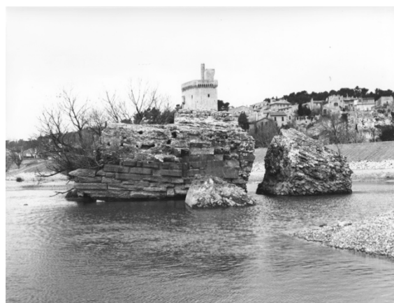
Fig. 8 - Pile 6-CNR (cliché AV.162 CNR 4/12/1969)
