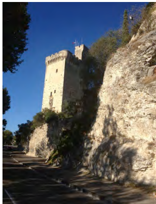
Le rocher de Saluce et la route de berge depuis le nord
