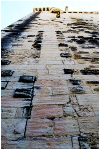
Conduits, bretèche, gargouille
