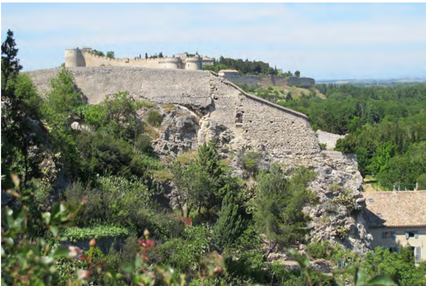
Mur nord du domaine Orsini, face sud, avec arrachement d'une tour (G du plan)
