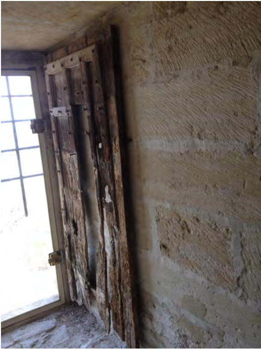
Porte en place d'accès au chemin de ronde
