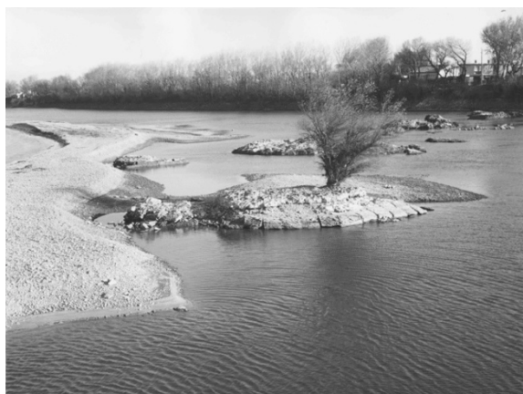
Fig. 7 - Pile 7-CNR (cliché AV.177 CNR 16/12/1969)
