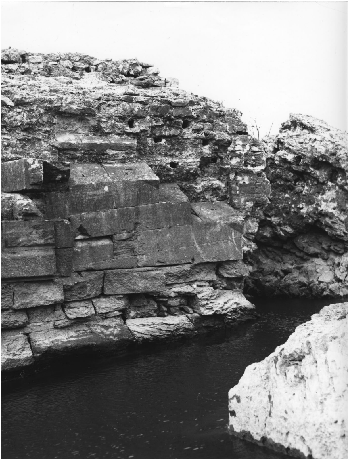
AV 165 – Pile 7, en 1969 avant dérasage selon la CNR (pile n° 16)
