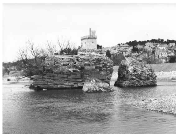
Fig. 8 - Pile 6-CNR (cliché AV.162 CNR 4/12/1969)
