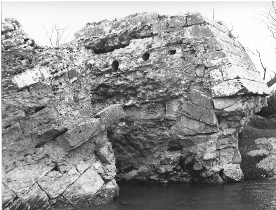
Figure 11 – Le glacis de la pile 17, vu de l'amont – cliché CNR 4/12/1969
